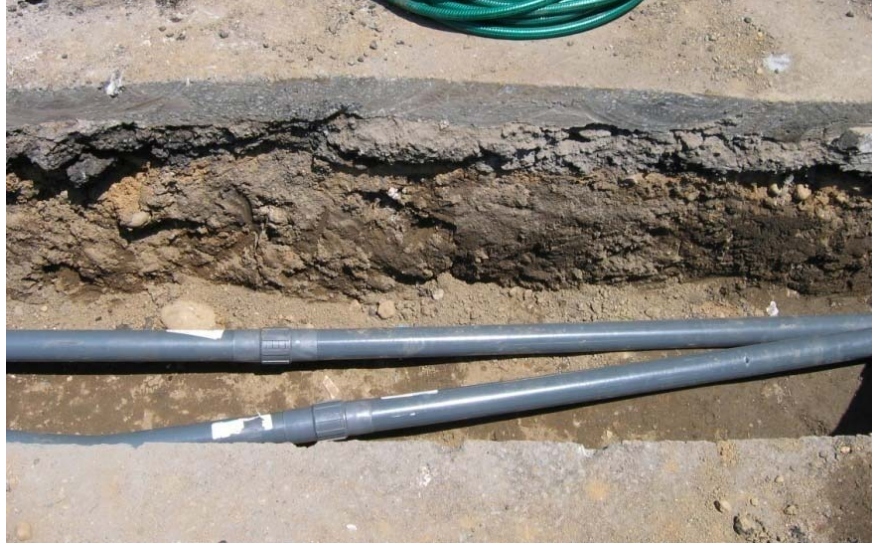
Image 23: Electrical conduits
